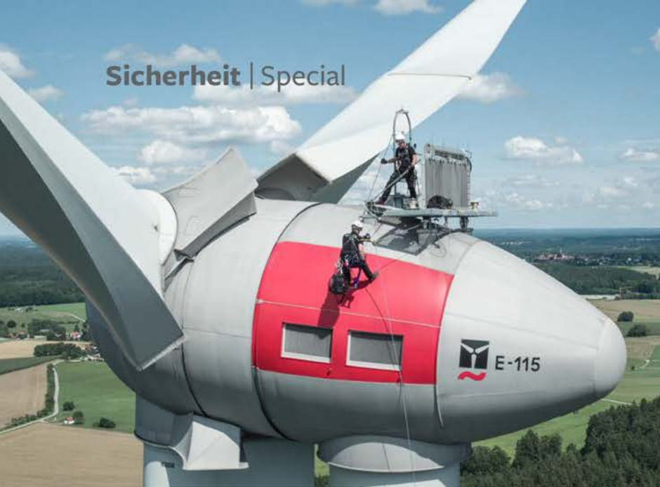
Neue Seiltechnik für das zeitgleiche Abseilen auch von zwei Mitarbeitern mitsamt Werkzeug
