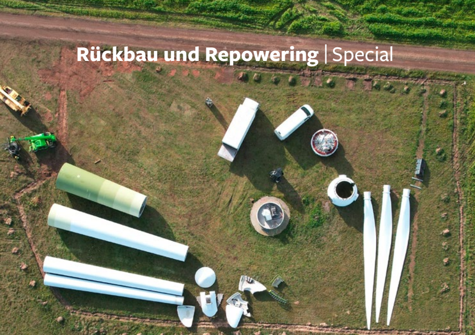
Aufgeräumte Rückbau-Baustelle mit Altanlagenkomponenten
