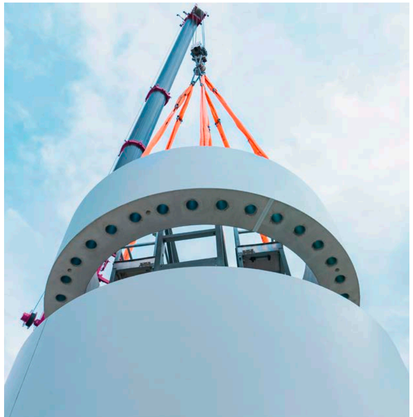
Fuchs-Europoles-Turmsegment beim Aufbau
