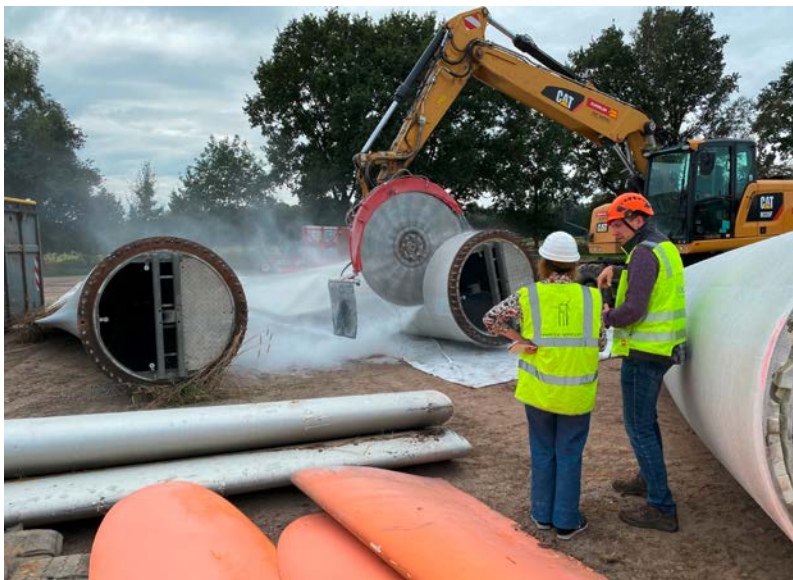
Rotorblattzerlegung durch inzwischen als Vidia-Tochter firmierendes Unternehmen Neowa
