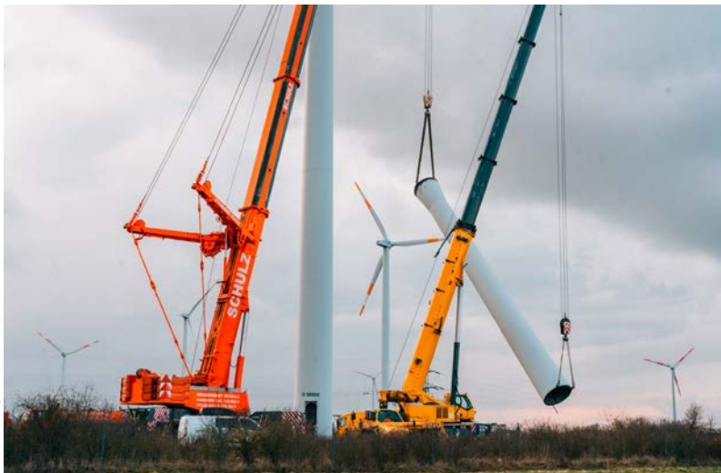
Rückbau für geplanten Repowering-Windpark mit künftig zwölf Megawatt bei Roitzsch 2024
