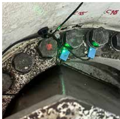
Aufbau der Identiflight-Kameratechnik links und oben. Bolzensensorik von Altosens in den Unterlegscheiben (unten Mitte und rechts)
