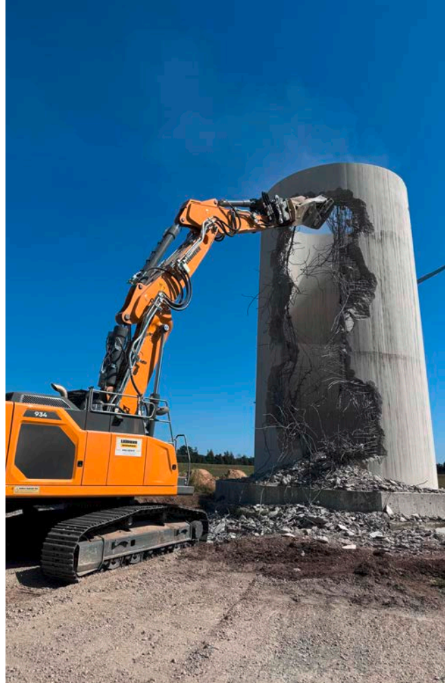
Rückbau im Windpark Teglingen am Turmsockel
