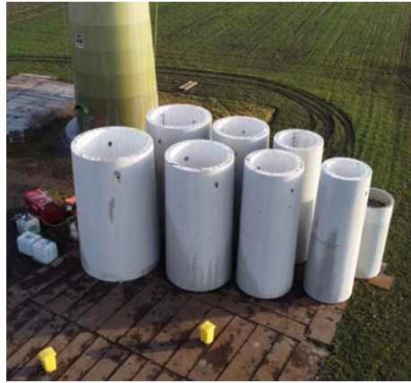
MFB-Betonturmzerlegung durch Rückbaubühne mit Karussell fahrender Kreissäge (links oben). Beispiel Olpe: ein Kran stellt die abgesägten Segmente eines 97 Meter hohen Betonturms auf einer vorbereiteten Fläche ab und senkt die Arbeitsbühne anschließend in die nächste Etage hinab (oben rechts und unten links). Unten: Rückbau der Altanlagen im VSB-Repowering-Projekt Löberitz
