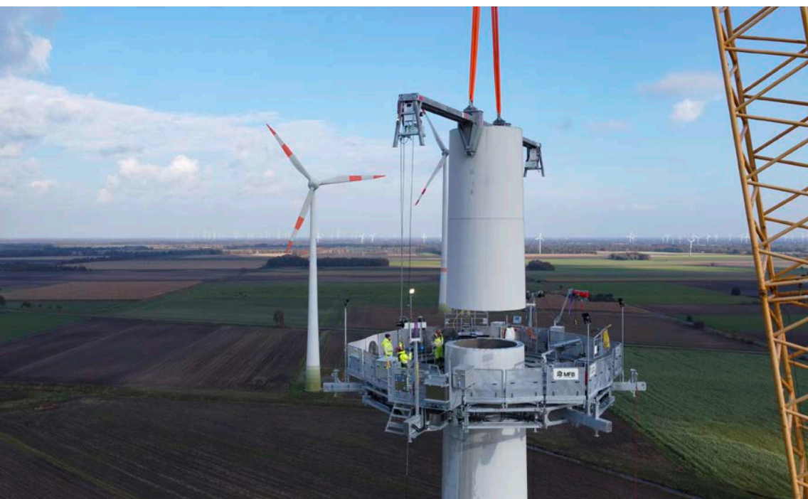
Foto: MFB Bauunternehmen
