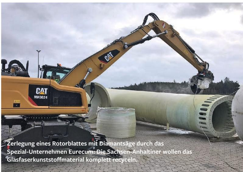
Zerlegung eines Rotorblattes mit Diamantsäge durch das Spezial-Unternehmen Eurecum: Die Sachsen-Anhaltiner wollen das Glasfaserkunststoffmaterial komplett recyceln.
